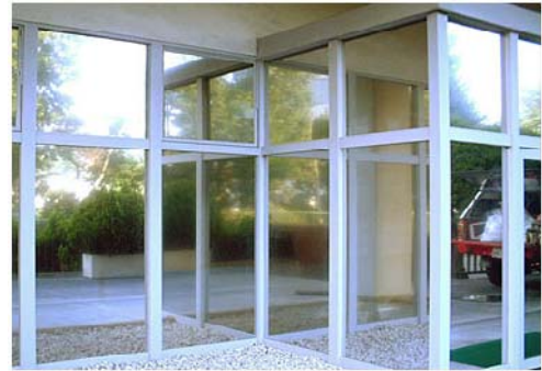
図 2) 熱線反射フィルム施工イメージ
