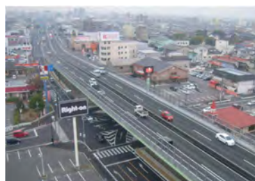
＜大気質対策＞ (交差点立体化 [国道2号])
