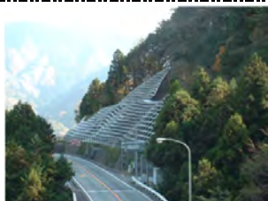
< 斜面崩落防止対策 >
