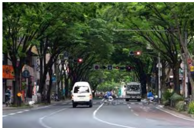
＜緑陰道路＞ （福岡市中央区赤坂地区）
