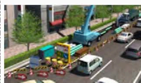
夏にガス工事
