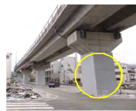
< 橋脚の耐震補強 >
