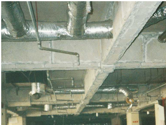
鉄骨耐火被覆
