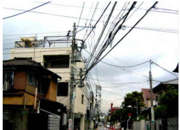
▲ 電線類により景観が損なわれている街なみ
