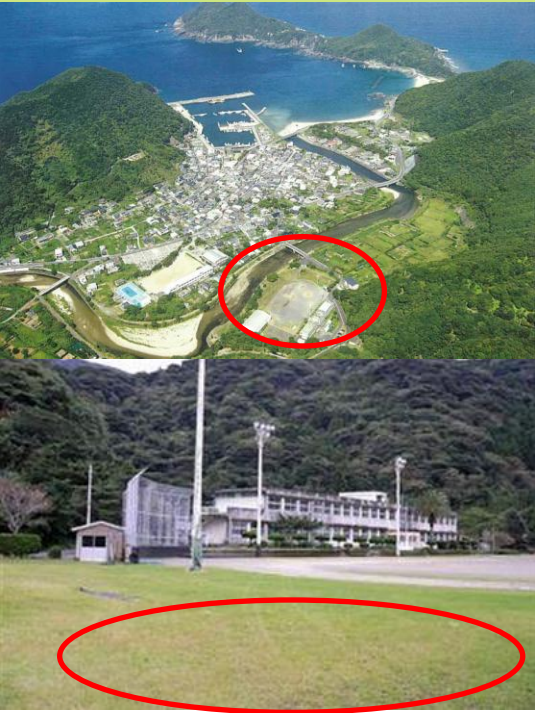
地中熱探熱管埋設エリア
