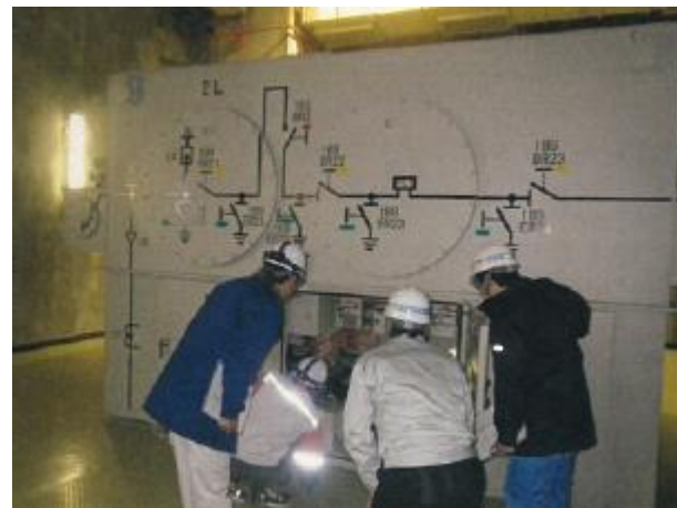
電気関係現地調査
