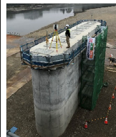
従来施工 （高所での測量）
