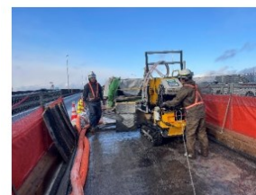
<ウォータージェットはつり処理工法>
