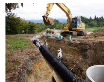
排水構造物工（暗渠排水管）
