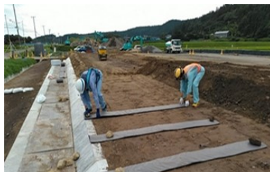
排水材設置工（水平排水層）
